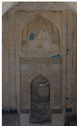
تصویر ۳۶: ورودی اولیه بنا از داخل
