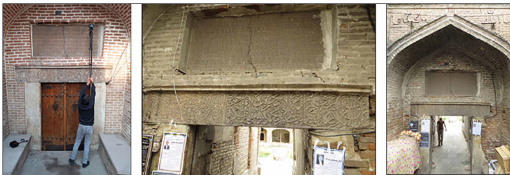
شکل ۱۳. تصاویری از سردر مجموعه حسن پادشاه قبل از عملیات مرمت و ساماندهی و حین عملیات برداشت پس از ساماندهی.
