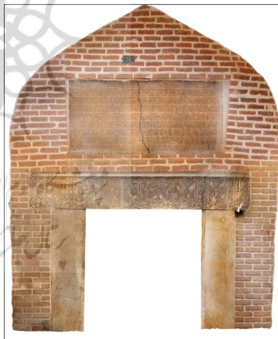
شکل ۱۴. تصویر ارتوفتوی تهیه شده از سردر مجموعه حسن پادشاه تبریز که به صورت مستقیم و بدون پرسپکتیو با نرم افزار متا شپ تهیه شده است.
